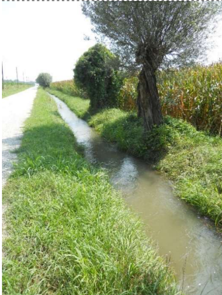
Figura 23 – Fascia inerbita lungo canale irriguo (Foto: E. Artusio)
