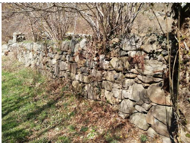
Figura 35 – Muretti a secco in Val Chiusella (Foto: E. Gottero)
