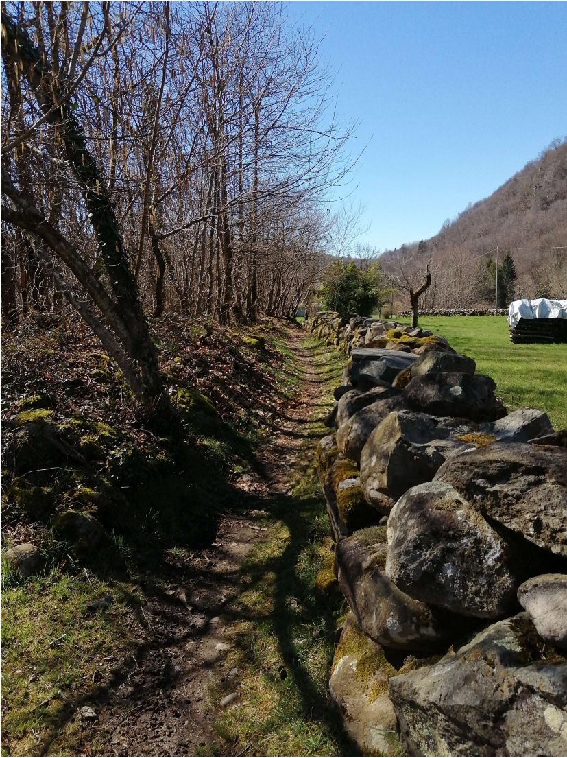
muretti a secco
